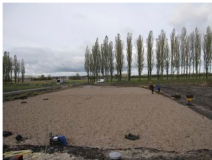
Aanleg verticaal doostroomd helofytenfilter (foto's Global Wetlands BV)
