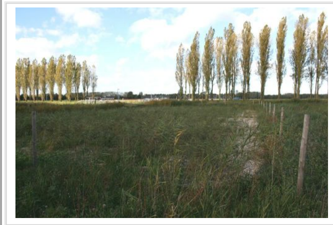
Verticaal doorstromend helofytenfilter (VHF) C.10
